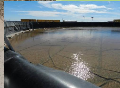
**Vista de un tanque tipo australiano de 2.000 m<sup>3</sup> de capacidad para almacenamiento de agua dulce en el Yacimiento Los Toldos.**
