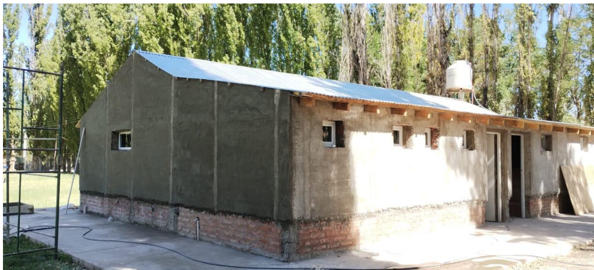
Obra ampliación Sanitarios de Caballeros
