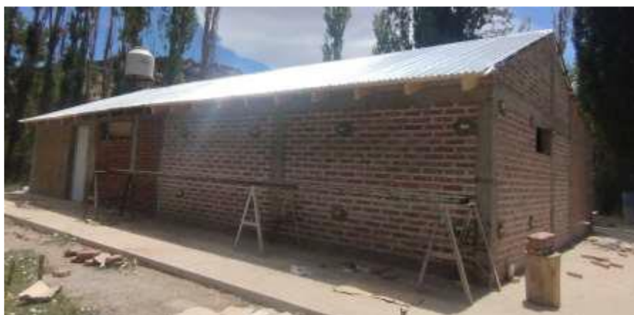
Techo nuevo en ampliación
