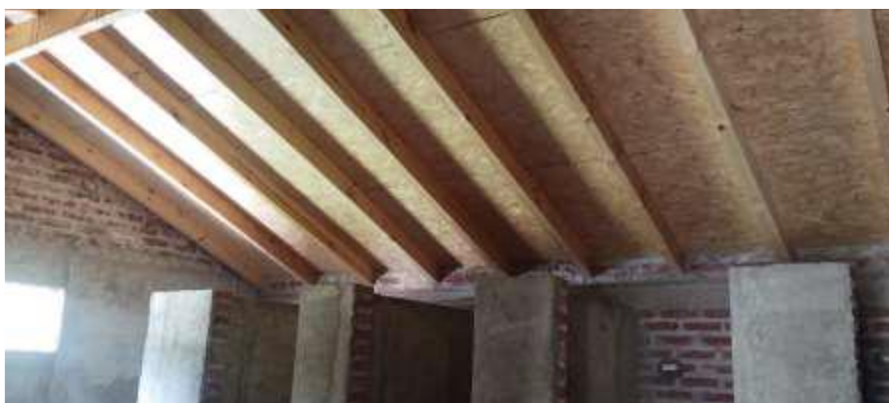
Techo nuevo en edificación existente
