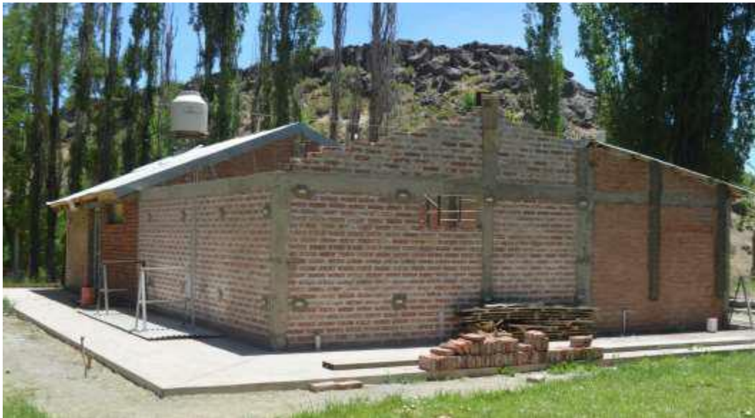
Sanitarios del camping Municipal – durante la obra de ampliación y refacción
